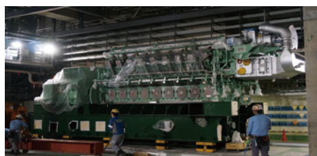
写真-2 六本木ヒルズの地下にある5,750kWのガスエンジン発電機
